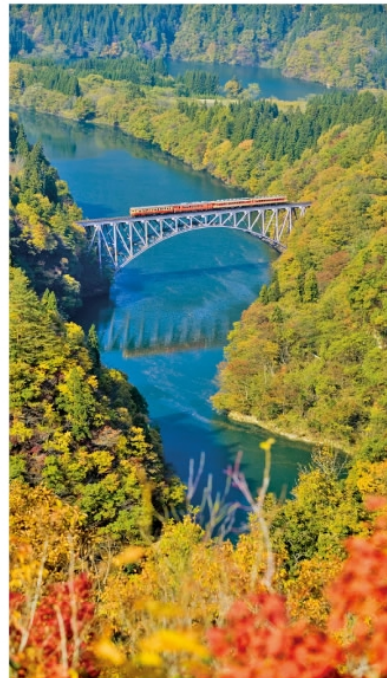
▲只見線第一橋梁
